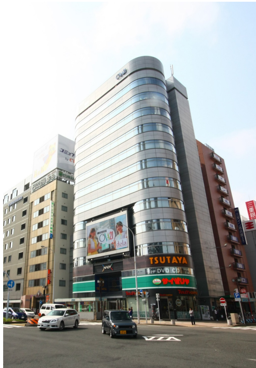
OVA21ビル（名古屋駅新幹線口）
